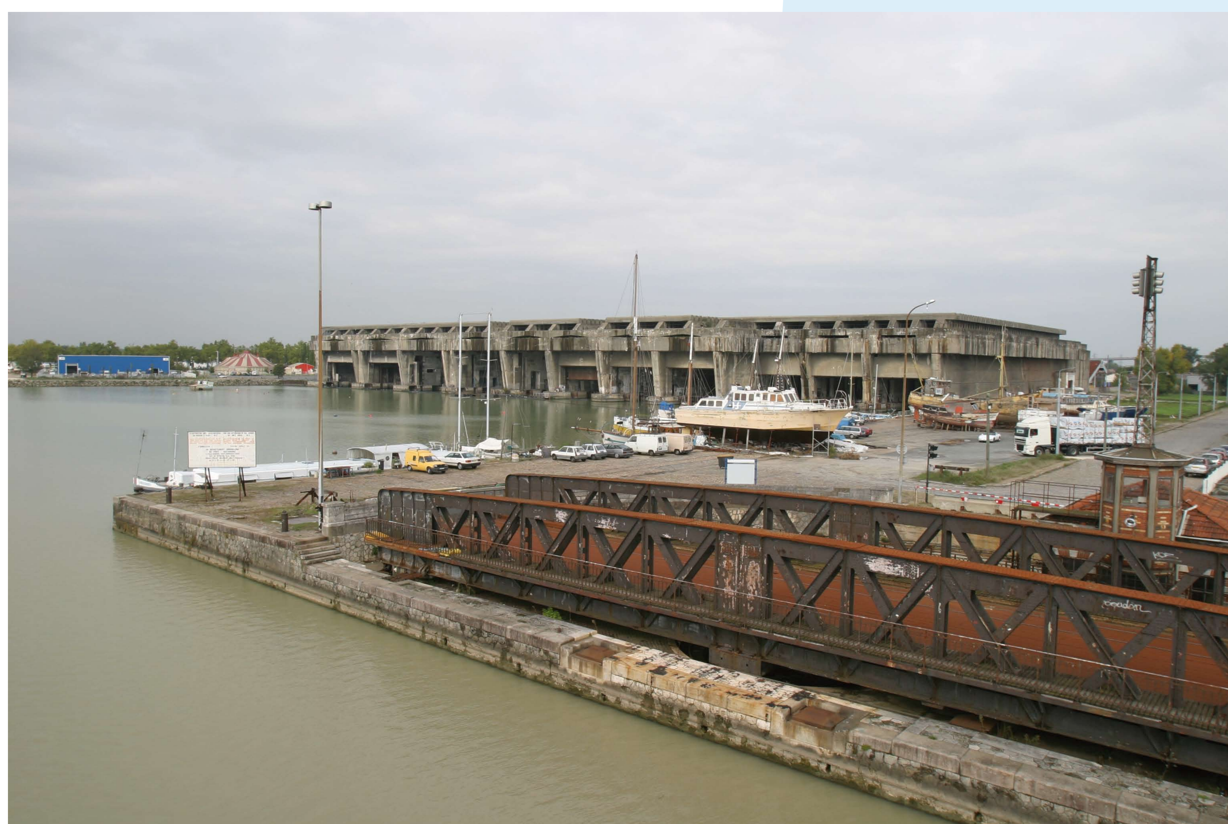
Le pont Pertuis avant sa démolition, (cliché Thomas Sanson 2005).
